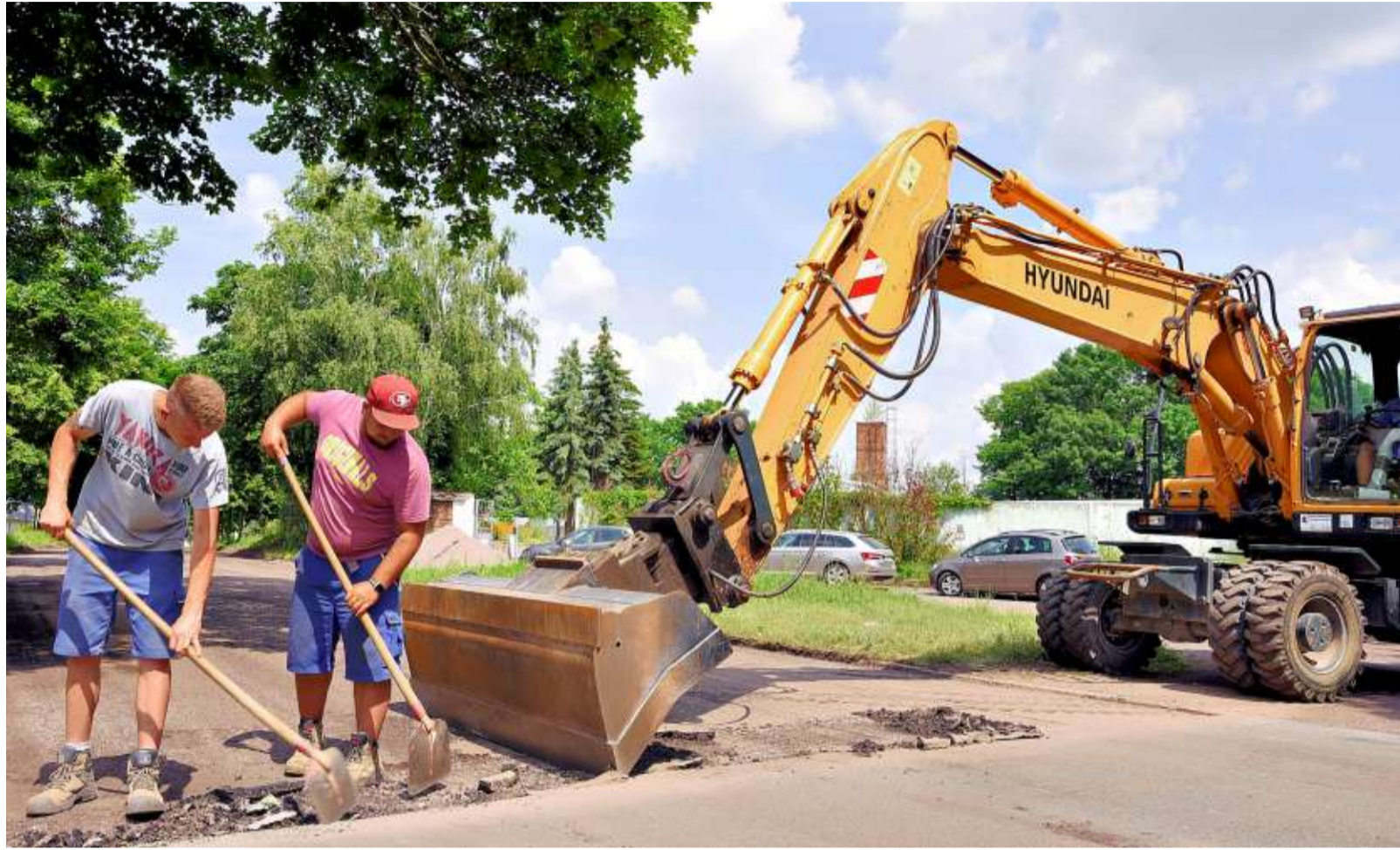
Philipp Ganß (links) und Patrick Eisfeld bei den letzten Arbeiten in der Halleschen Straße von Görzig.
